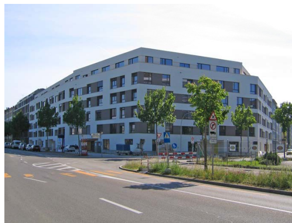
Fassade Ecke Riehenring / Horburgstrasse
