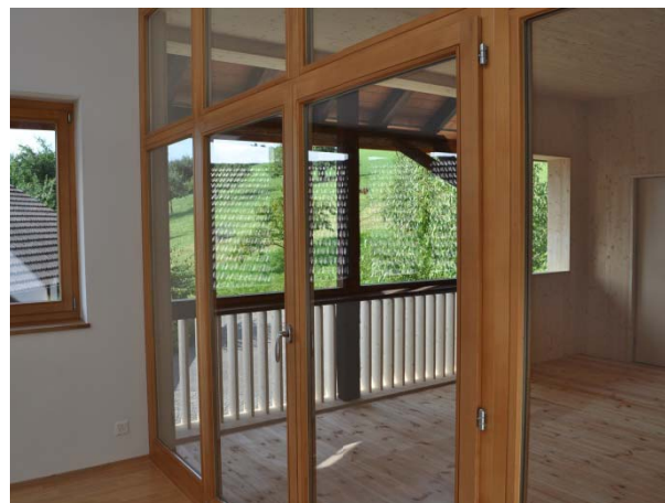
Blick auf Loggia
